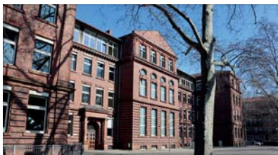
Das unter Denkmalschutz stehende Schulgebäude wird einer Generalsanierung unterzogen.
