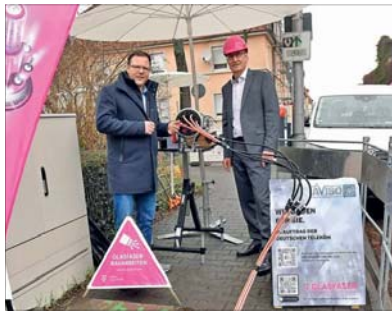
Bürgermeister Volker Proffen beim Glasfaser-Baustellenbesuch. Foto: Stadt Mannheim
