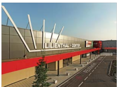
Die moderne Haustechnik des Lilienthal-Centers leistet einen Beitrag zum Energiesparen. Foto: Dr. Aldinger & Fischer
