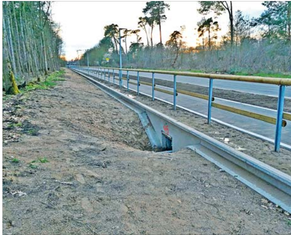
Kurz vor Fertigstellung des Geh- und Radweges wurden nun auch Amphibientunnels angelegt. Foto: Paesler
