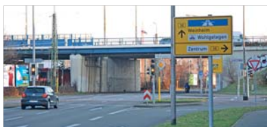
Die BBC-Brücke von der Zielstraße aus gesehen. Foto: Paesler
