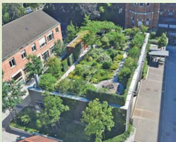
Auf Flachdächern sind wunderbare Gartenanlagen möglich. Foto: Bundesverband Gebäudegrün e.V./akz-o
