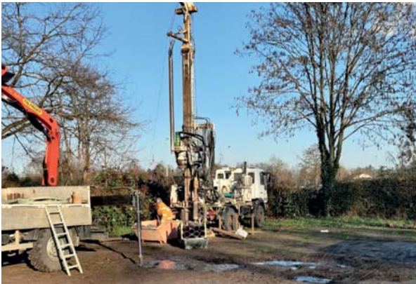
Aktuell müssen Brunnen, an denen Pumpversuche durchgeführt werden, gebohrt werden. Diese Arbeiten finden ab März bis in den Herbst 2025 statt. Foto: RPK
