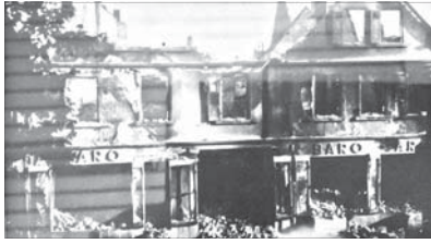
Das im Krieg zerstörte Gebäude wurde komplett wiederaufgebaut. Foto: zg
