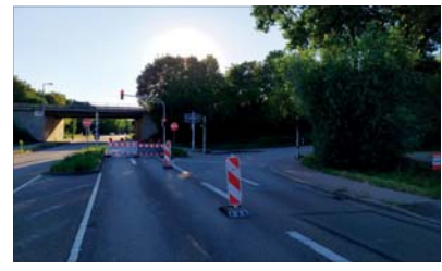
Im ersten Bauabschnitt ab 14. Mai ist die Auffahrt vom Gewerbegebiet Mallau (Mallaustraße) zur B 38a in Fahrtrichtung der SAP-Arena voll gesperrt. Foto: Kranczoch
