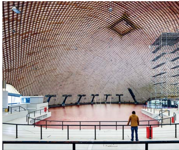
Die große Halle der Multihalle im Herzoegenriedpark.
