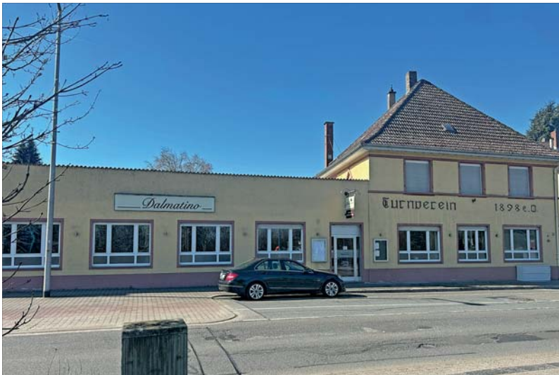
Das Gebäude, in dem sich bislang die Vereinsgaststätte befand, wird aufgestockt und die Fassade insgesamt ihr Gesicht verändern. Foto: Warlich
