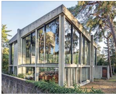
Die Pfingstbergkirche gilt als architektonische Besonderheit, birgt jedoch aufgrund ihrer Bauweise auch Herausforderungen.
